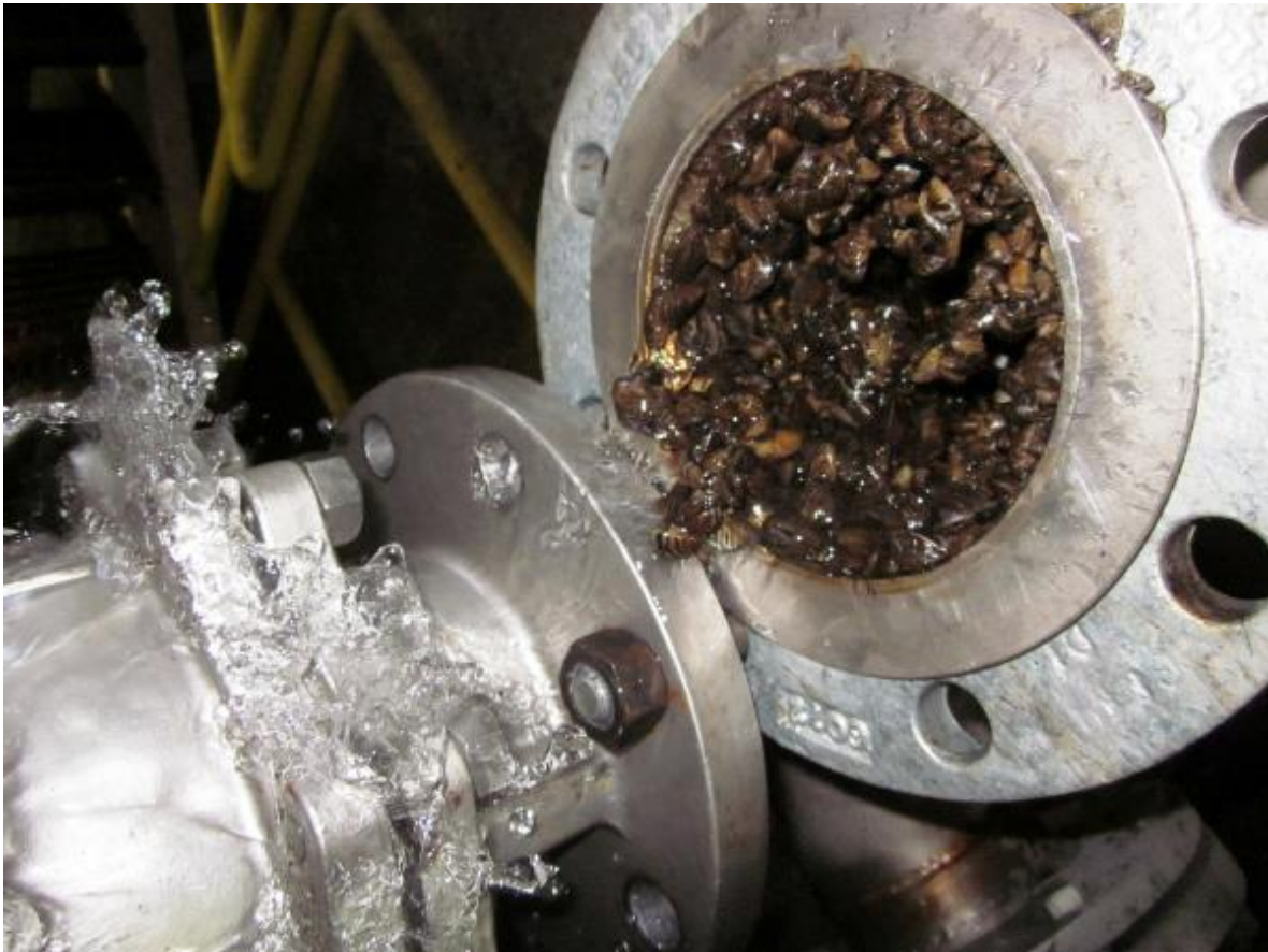
Figura 33. Obstrucción de tuberías por infestación del mejillón cebra (tomado de https://esemag.com/water/how-to-effectively-control-zebra-mussels/ ).
