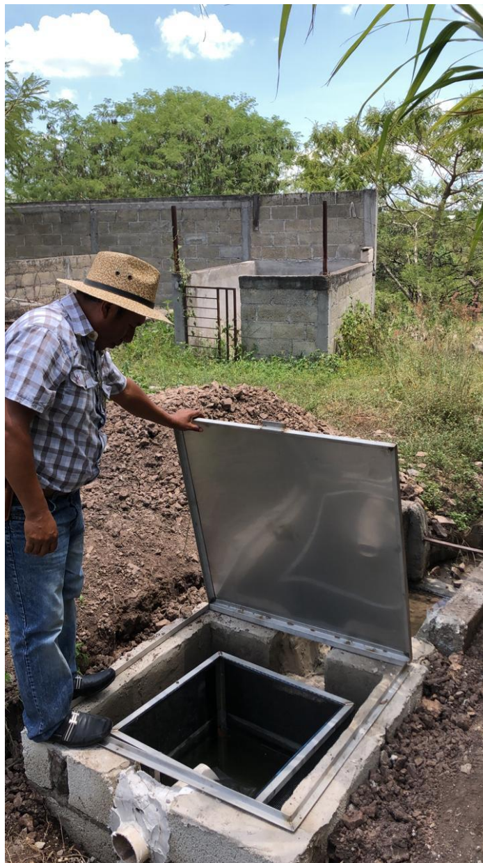
Registro para descarga de agua general con Trampa
