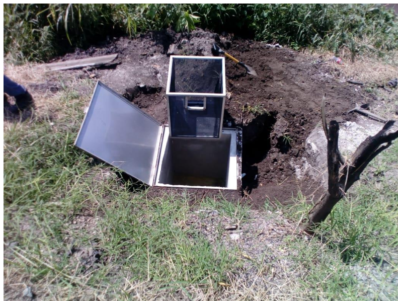
Ilustración 3 Diseño final de trampa, registro de 1x1m y tapa, instalados en las UPAS
