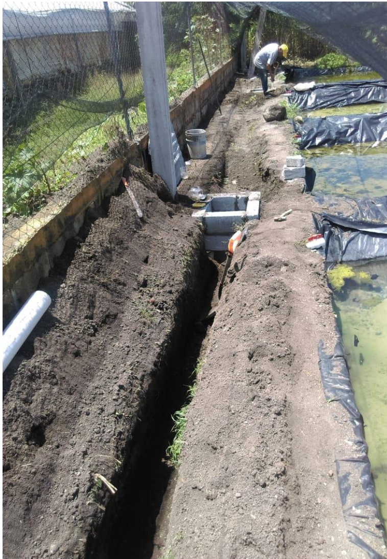
Sistema de desagüe para 6 registros intermedios
