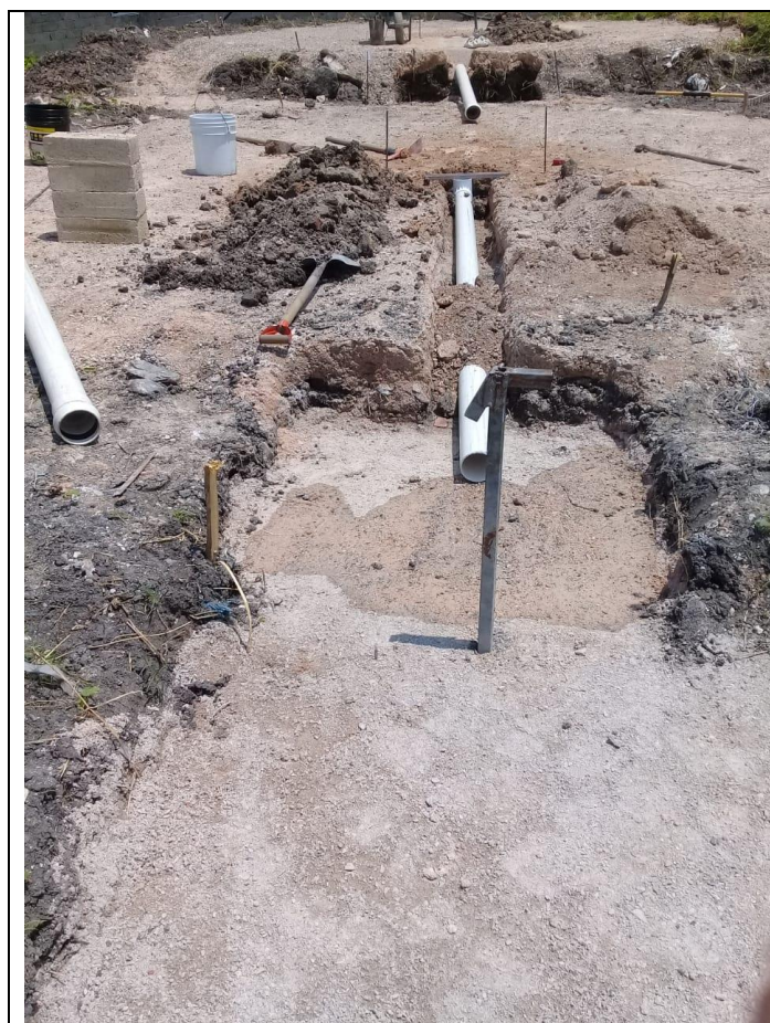
Instalación drenaje del Sistema de Recirculación
