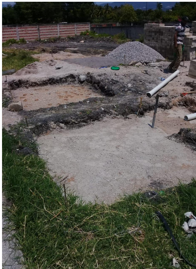
Compactación de materiales para colocación del sedimentador para RAS
