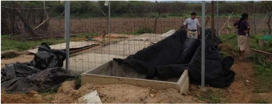
Figura 22.- Instalación del sistema biobolsa
