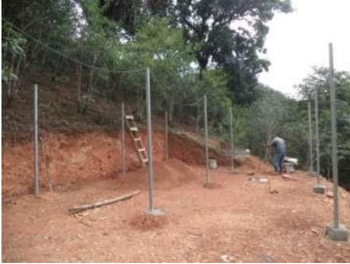
Figura 18.- Colocación de tubos PTR
