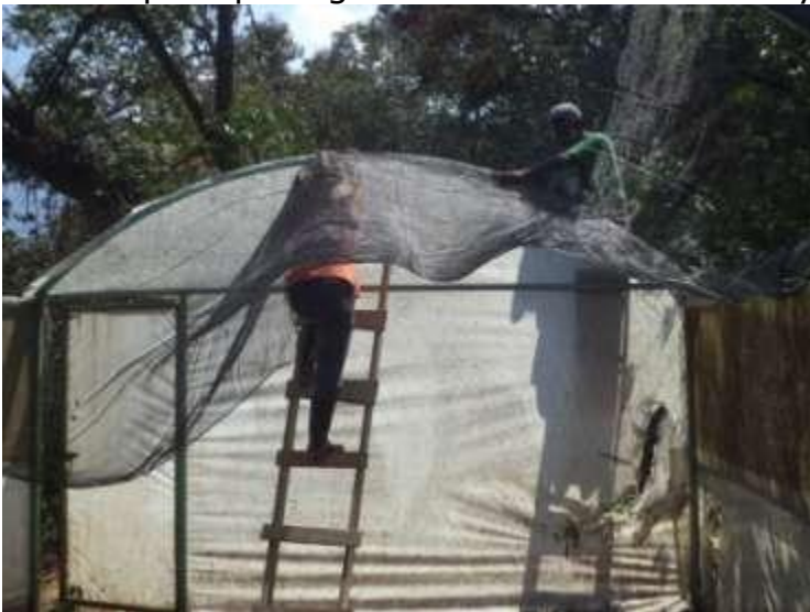
Figura 4.- Colocación de malla sombra
