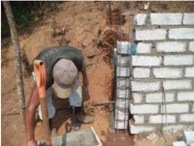
Figura 8.- Construcción del gallinero
