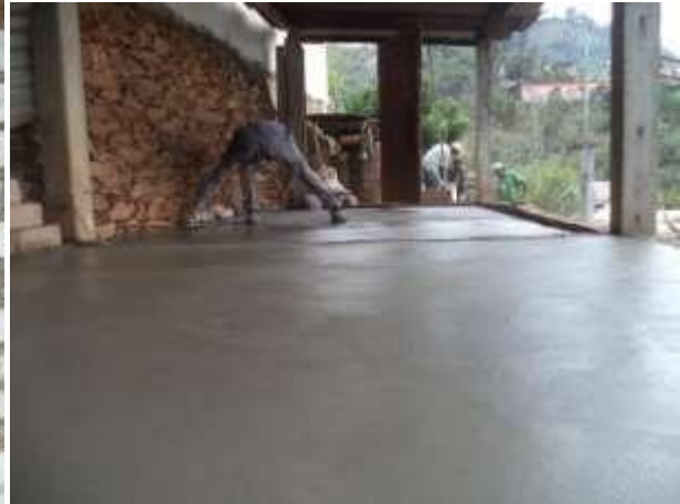
Figura 9.- Colocación de piso del corral de aves
