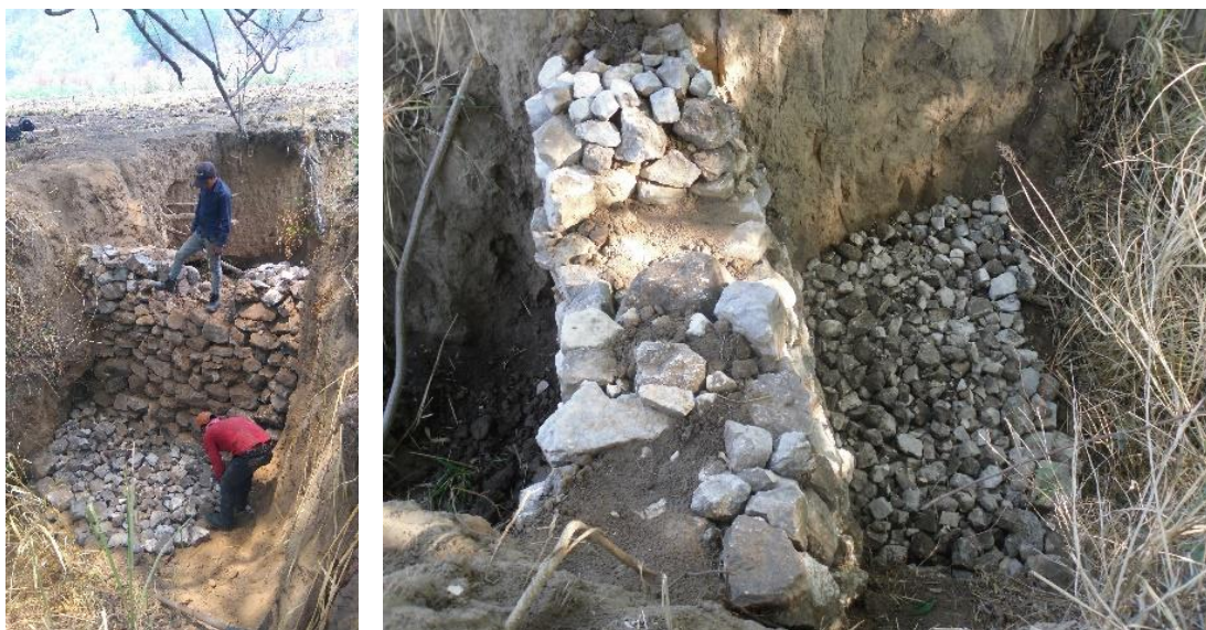
Figura 8: Proceso de construcción de presas filtrantes y delantal. Fotografías: Mainor Alexander Chanona Sandoval.
