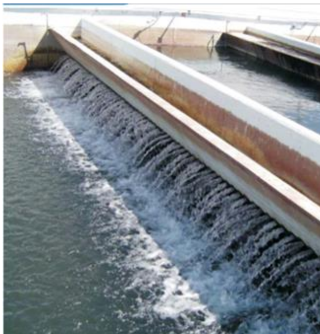
Figura 16. Tanque de filtración, potabilizadora El Florido. Fuente: https://www.cespt.gob.mx/culturaagua/pdf/articulos/Acueductos(03).pdf
