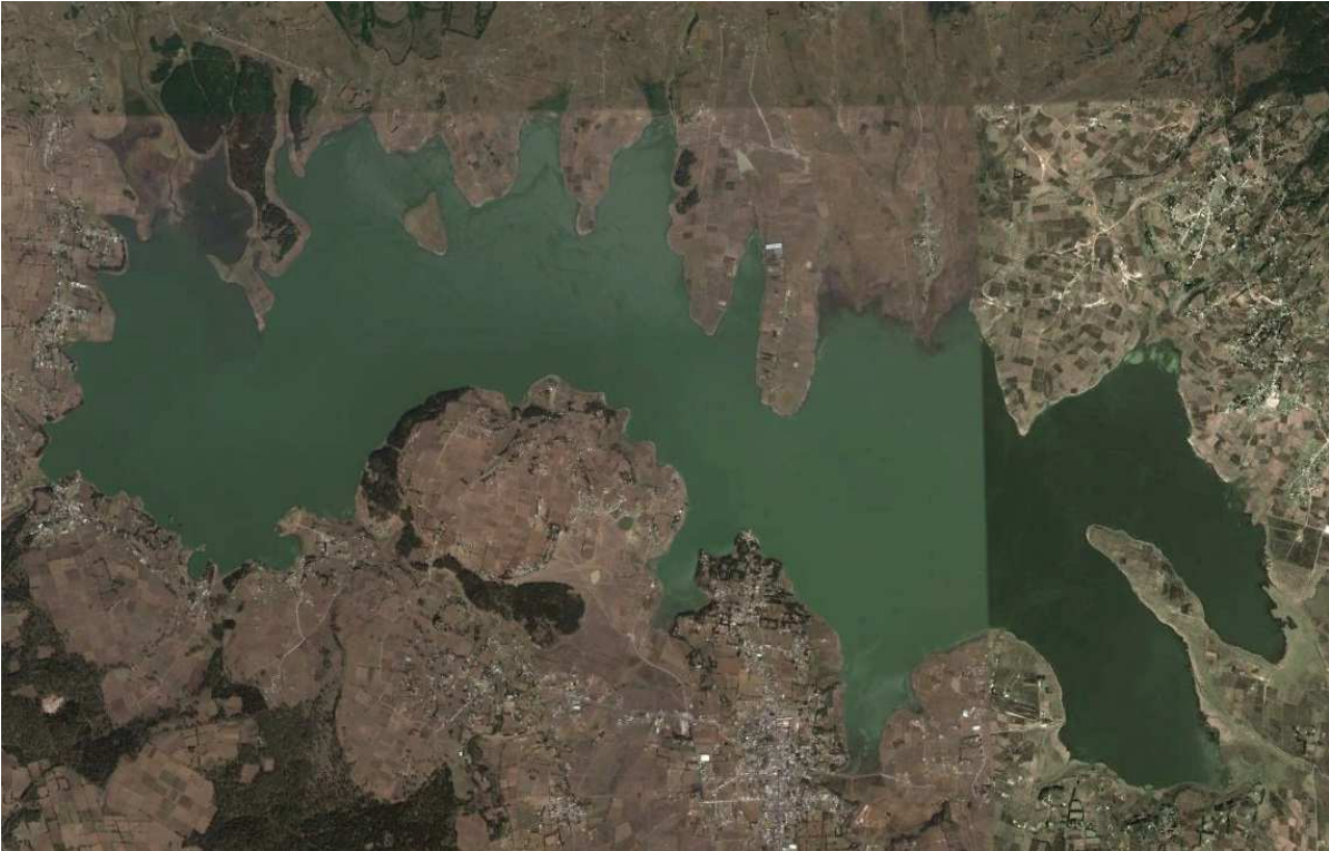
Imagen 24. Google 07/03/2015 Presa Villa Victoria 19°28'0.29"N 100 0'12.83"O
