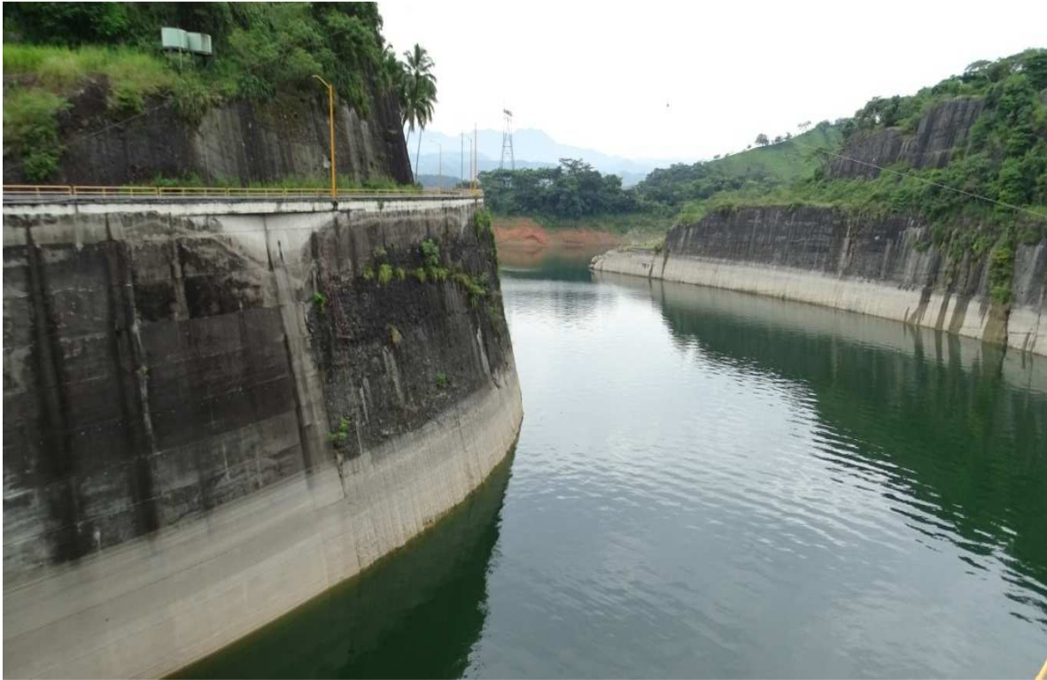
Foto 29. Canal de la Presa Malpaso
