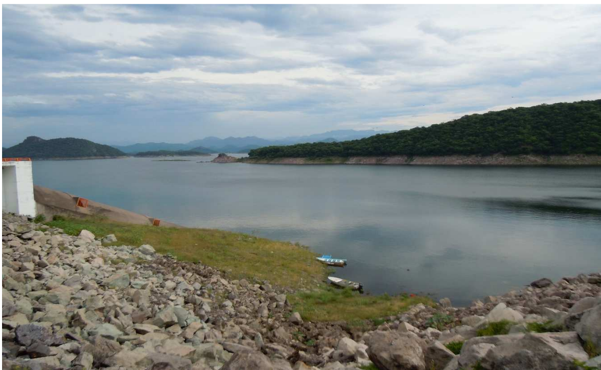
Foto 220. Vista general de la presa en las inmediaciones de la cortina
