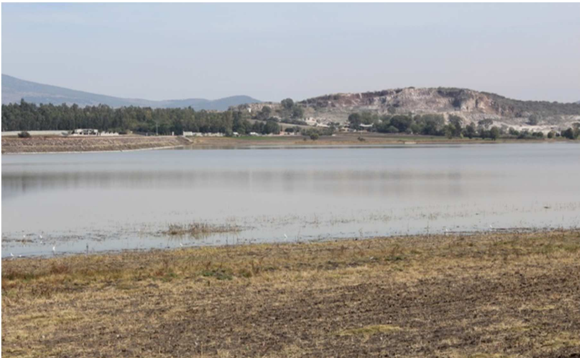
Foto 107. Vista General de la Presa Solís
