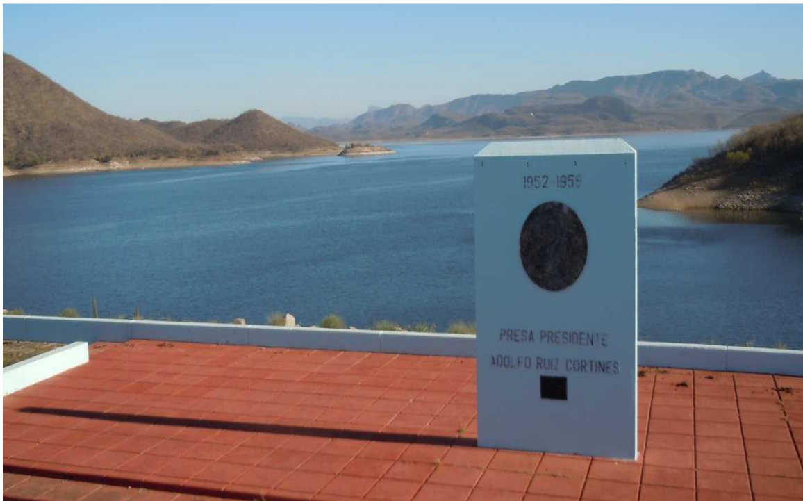
Foto 260. Presa Adolfo Ruíz Cortines (Mocuzari) libre de PAEI
