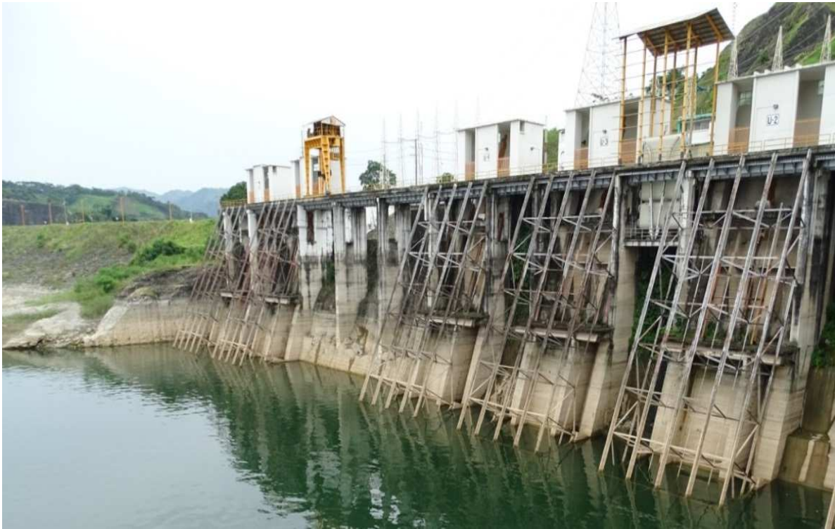
Foto 27. Cortina de la Presa Malpaso
