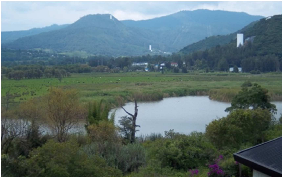
Foto 87. Vista General de la Presa Santo Tomas
