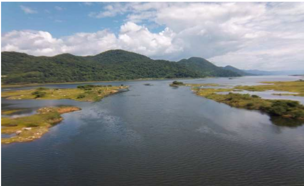
Foto 207. Vista General de la Presa Miguel de la Madrid Hurtado
