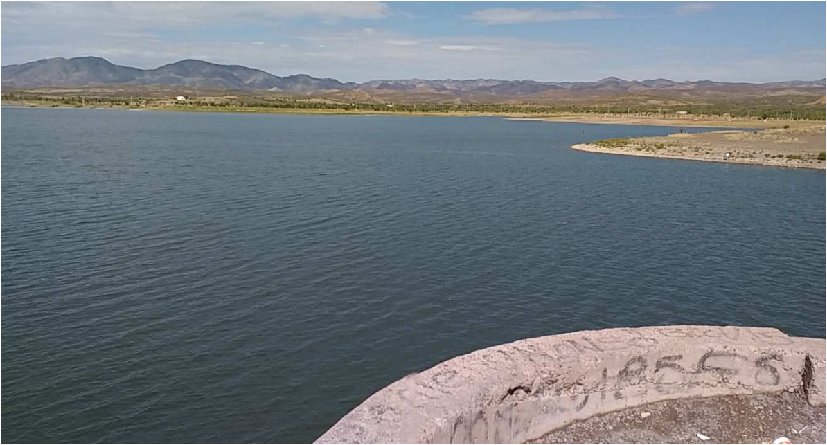
Foto 45. Presa libre de PAEI
