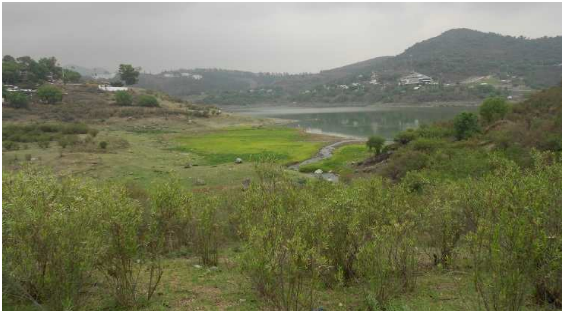
Foto 81. Vista General de la Presa Madín
