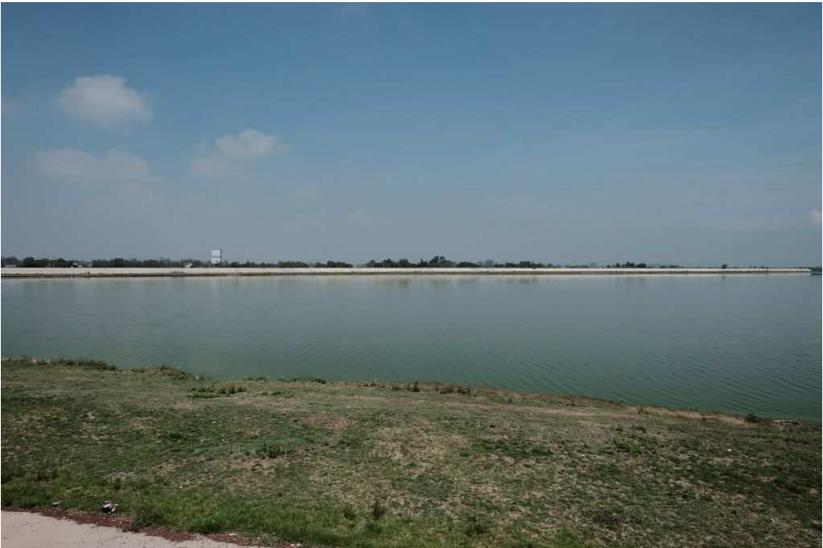
Foto 105. Presa libre de PAEI
