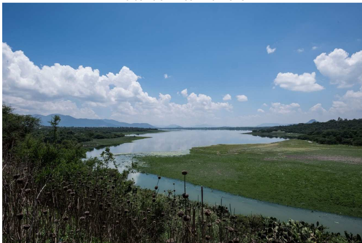
Foto 119. Vista general de la Presa Endhó
