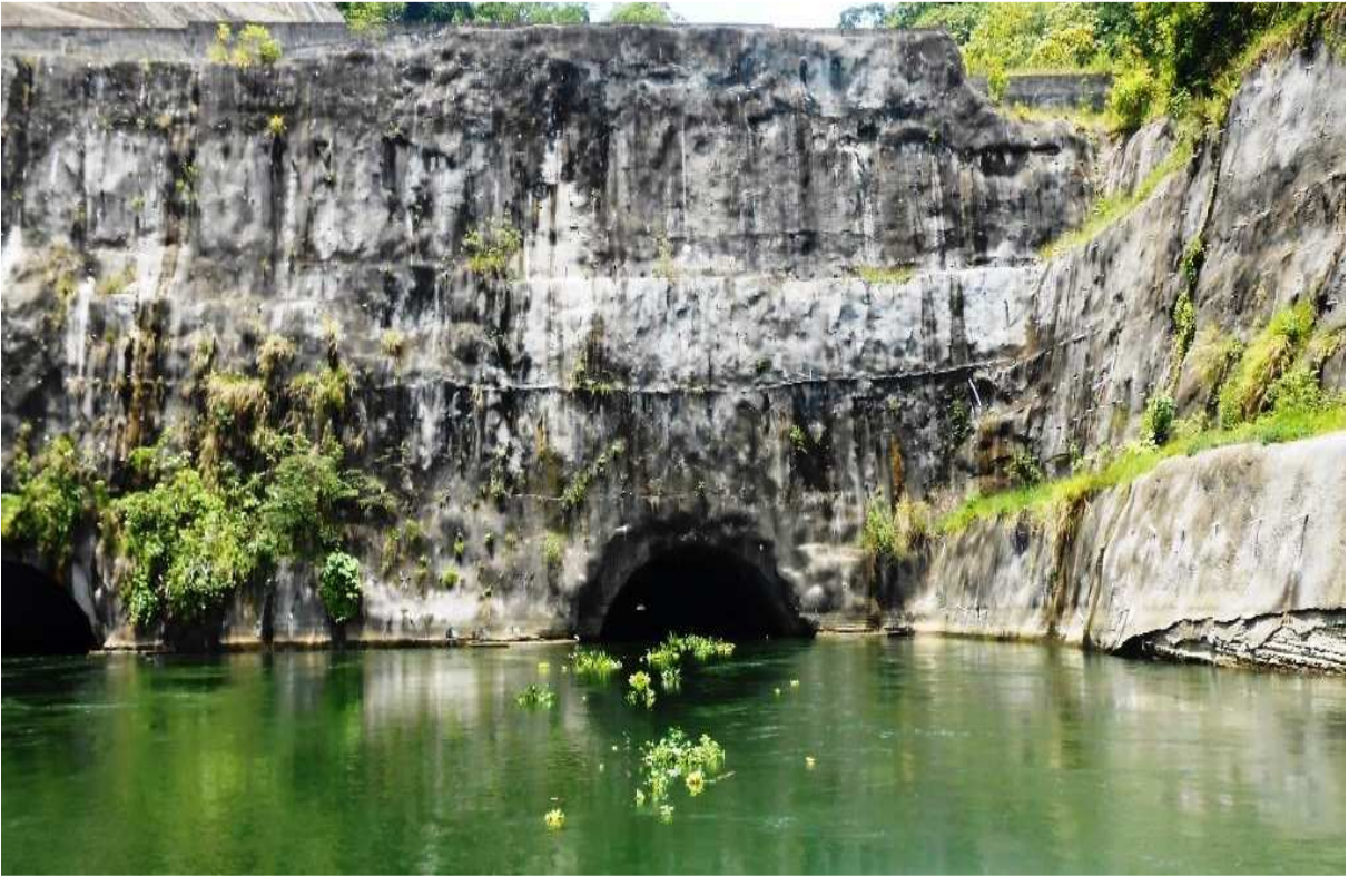
Foto 14. Entrada de Eichhornia crassipes a la Presa Peñitas a través del canal de Grijalva
