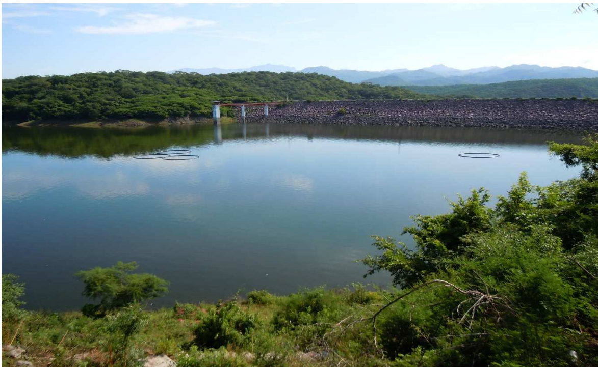
Foto 228. Cortina de la Presa El Salto
