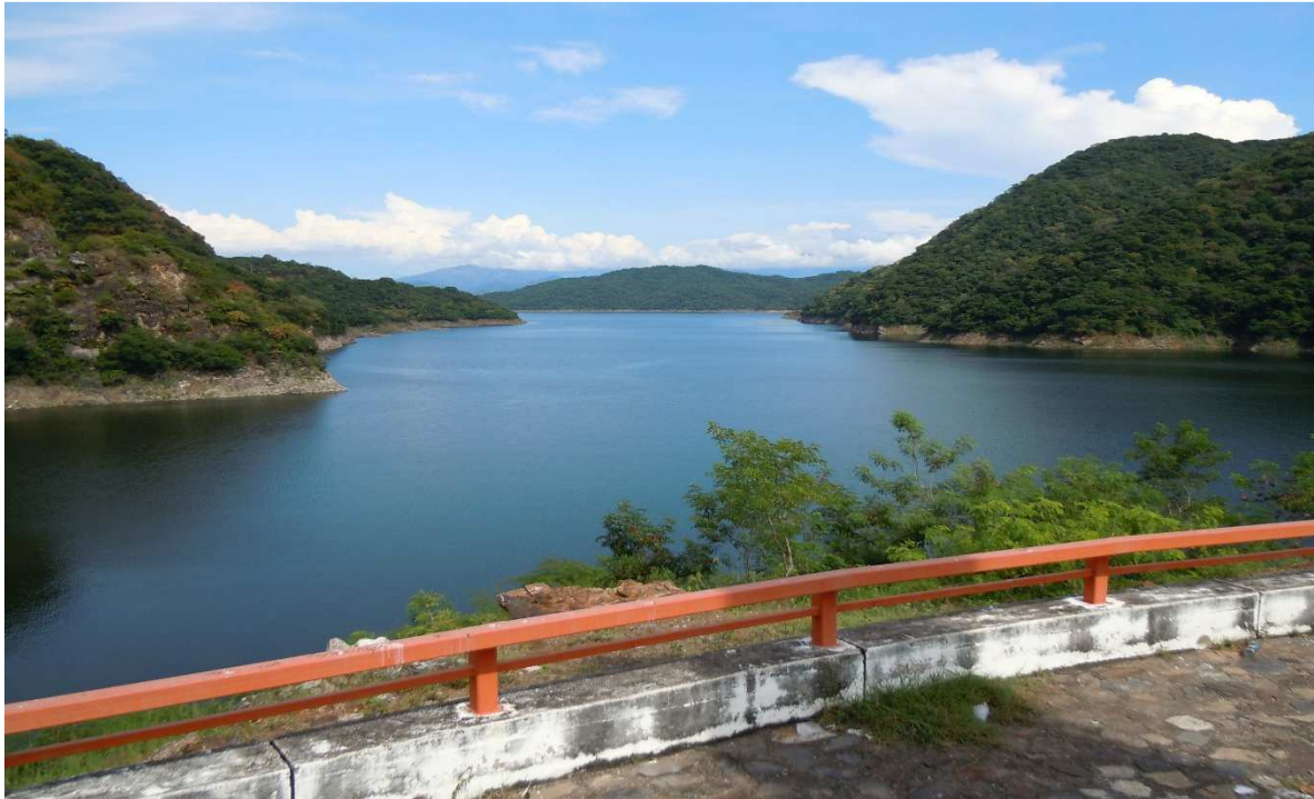
Foto 247. Vista general de la Presa José López Portillo
