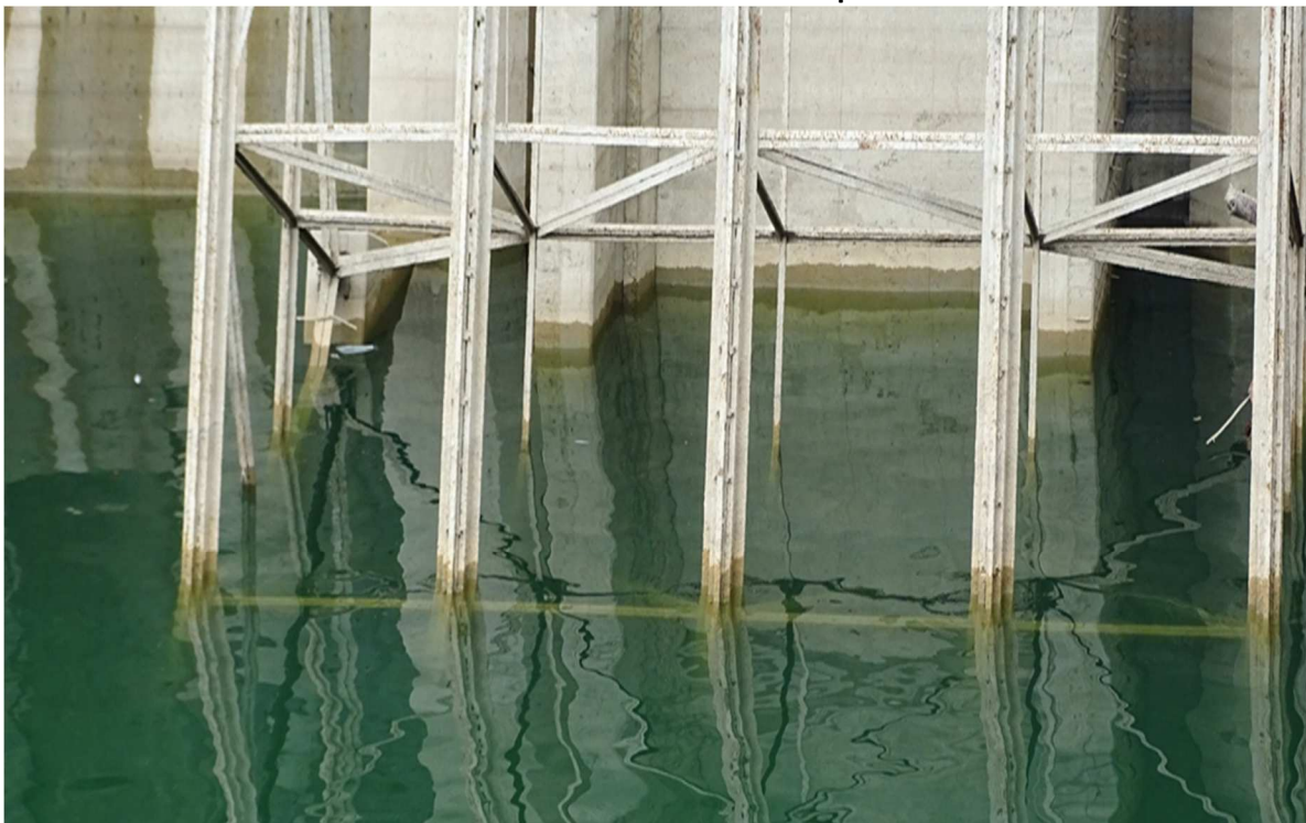
Foto 28. Acercamiento a la cortina de la Presa Malpaso
