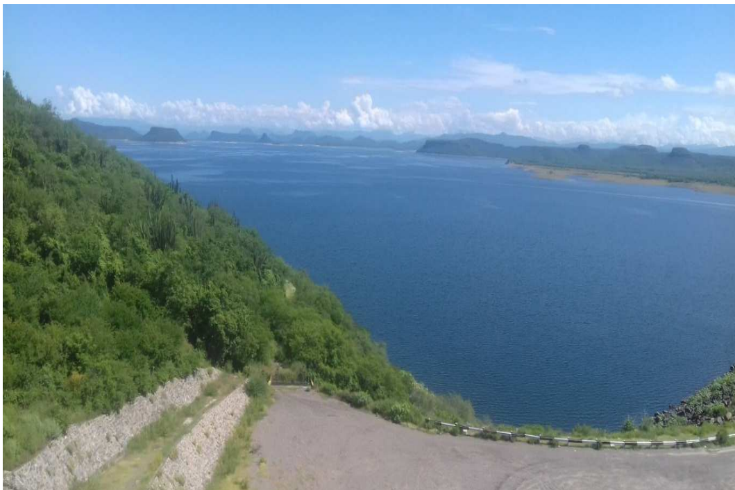
Foto 253. Vista panorámica de la Presa Miguel Hidalgo y Costilla
