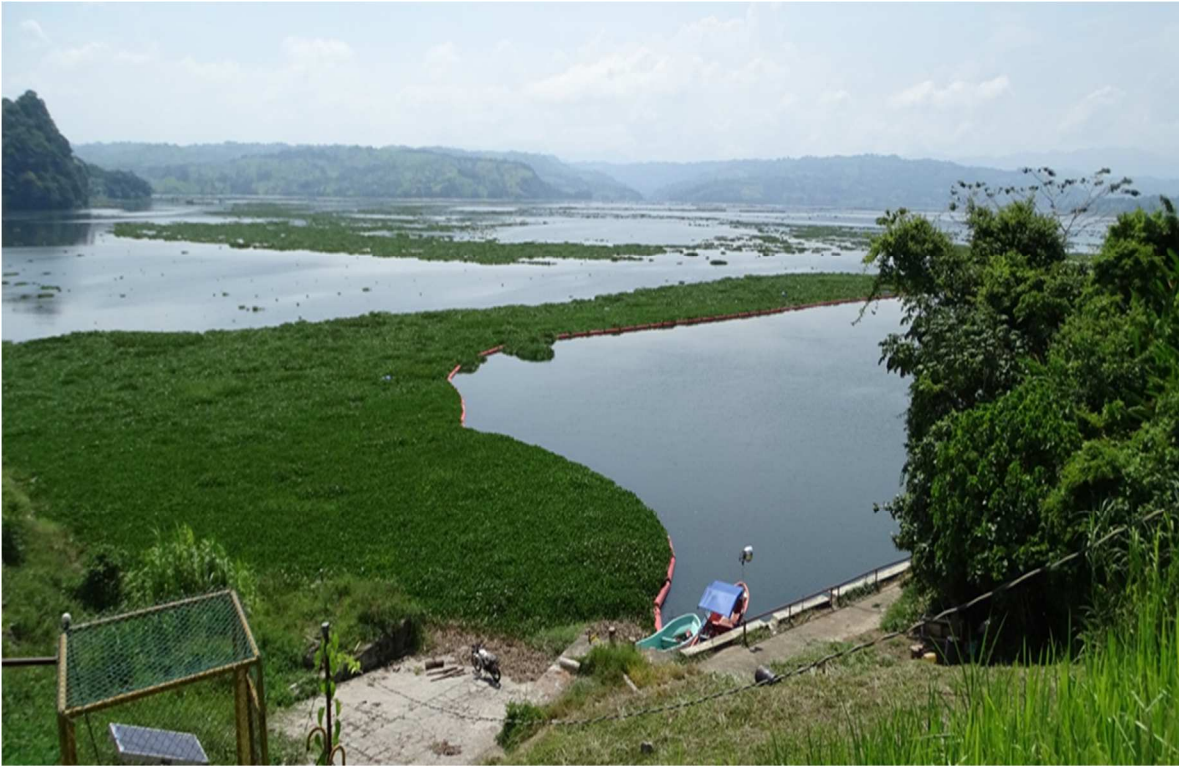
Foto 10. Barreras de contención de Eichhornia crassipes en compuerta de la Presa Peñitas
