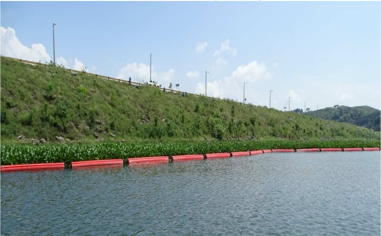
Foto 11. Acercamiento a la barrera mecánica para la contención de Eichhornia crassipes en la Presa Peñitas
