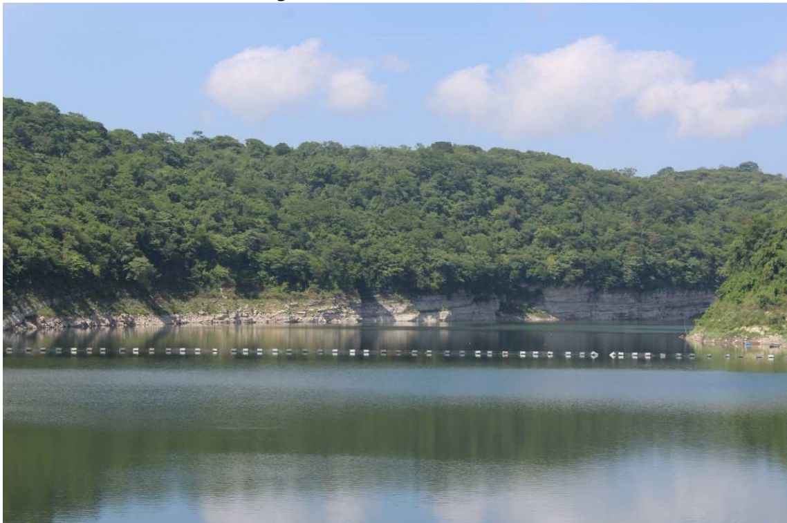
Foto 22. Vista panorámica de la Presa Manuel Moreno Torres
