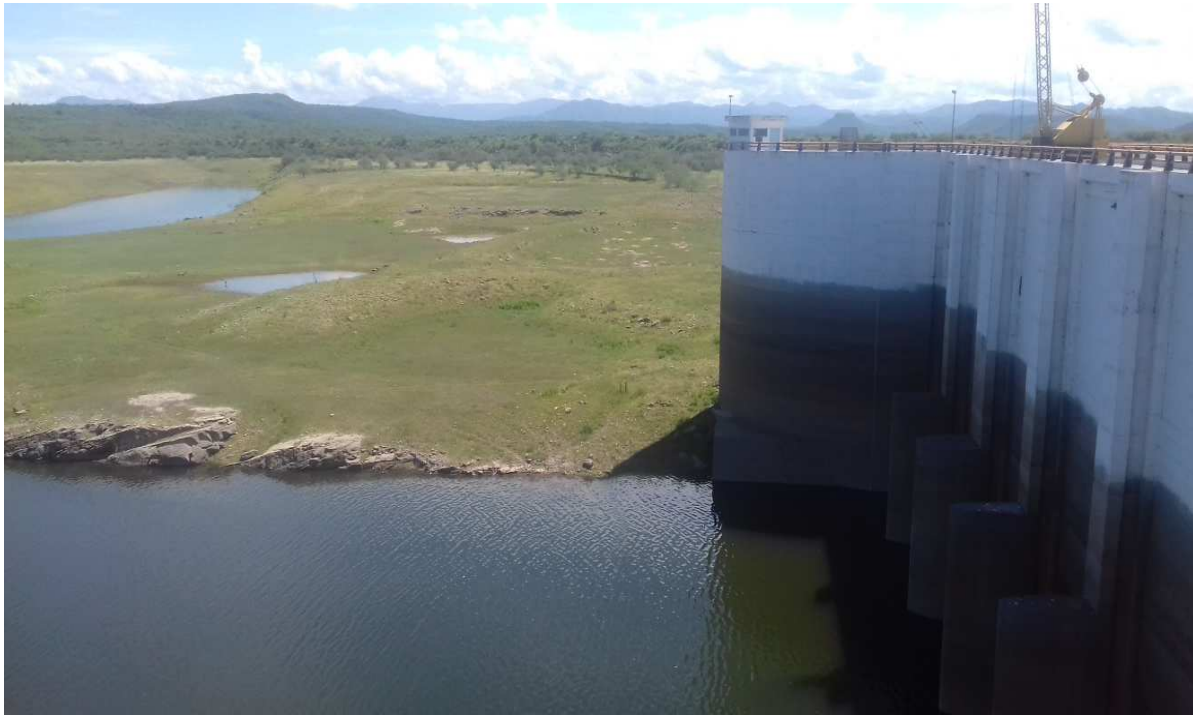
Foto 254. Cortina de la Presa Miguel Hidalgo y Costilla
