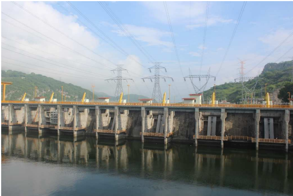
Foto 20. Compuertas de la Presa Manuel Moreno Torres
