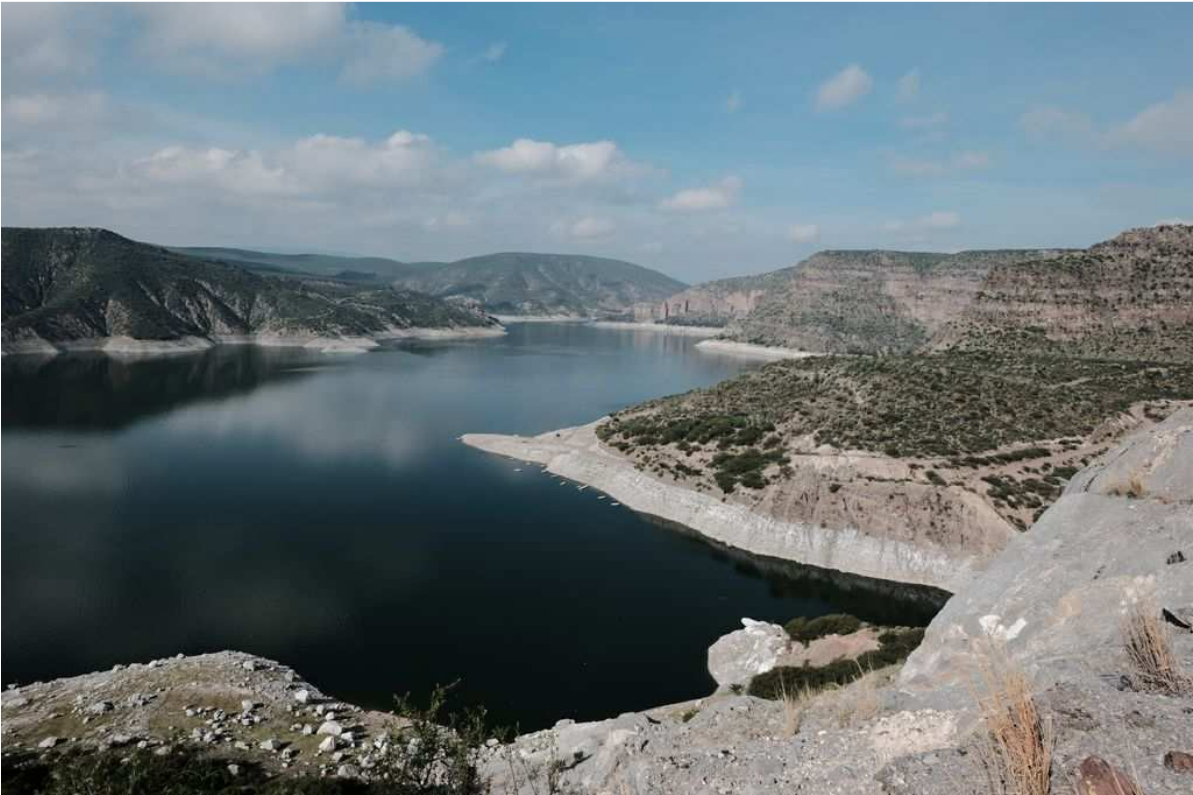
Foto 126. Presa libre de PAEI
