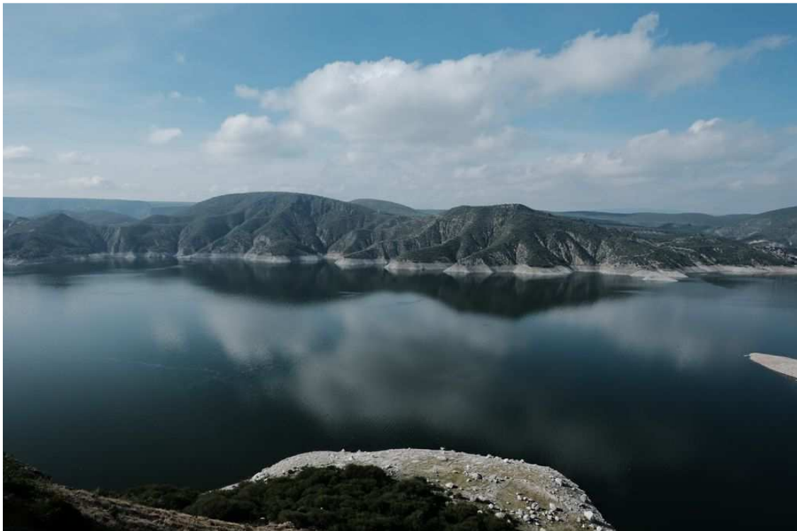
Foto 125. Vista panorámica de la Presa Ing. Fernando Hiriart Balderrama
