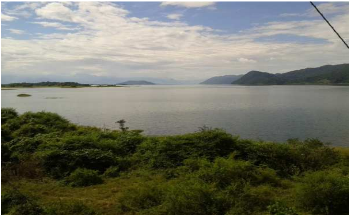
Foto 209. Vista General de la Presa Presidente Miguel Alemán
