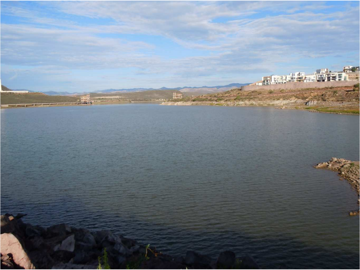
Foto 50. Presa libre de PAEI
