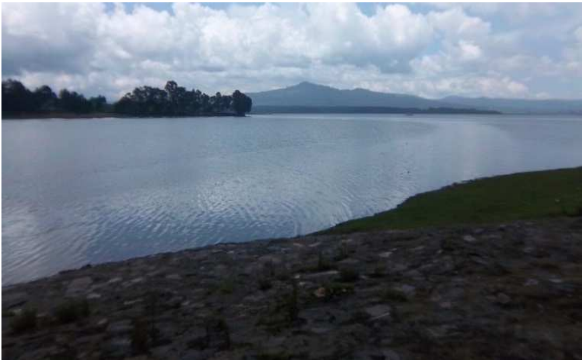
Foto 100. Vista General de la Presa Villa Victoria
