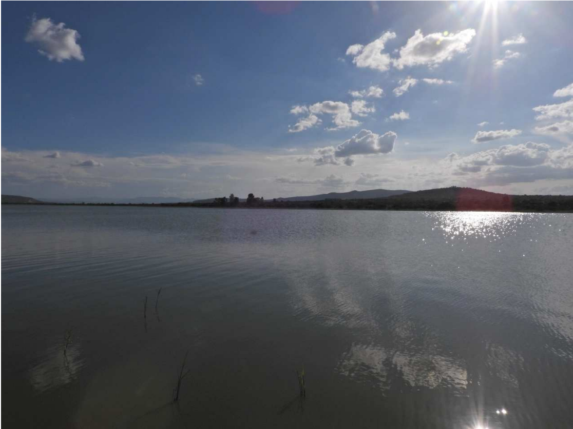
Foto 217. Acercamiento a la Presa El Centenario
